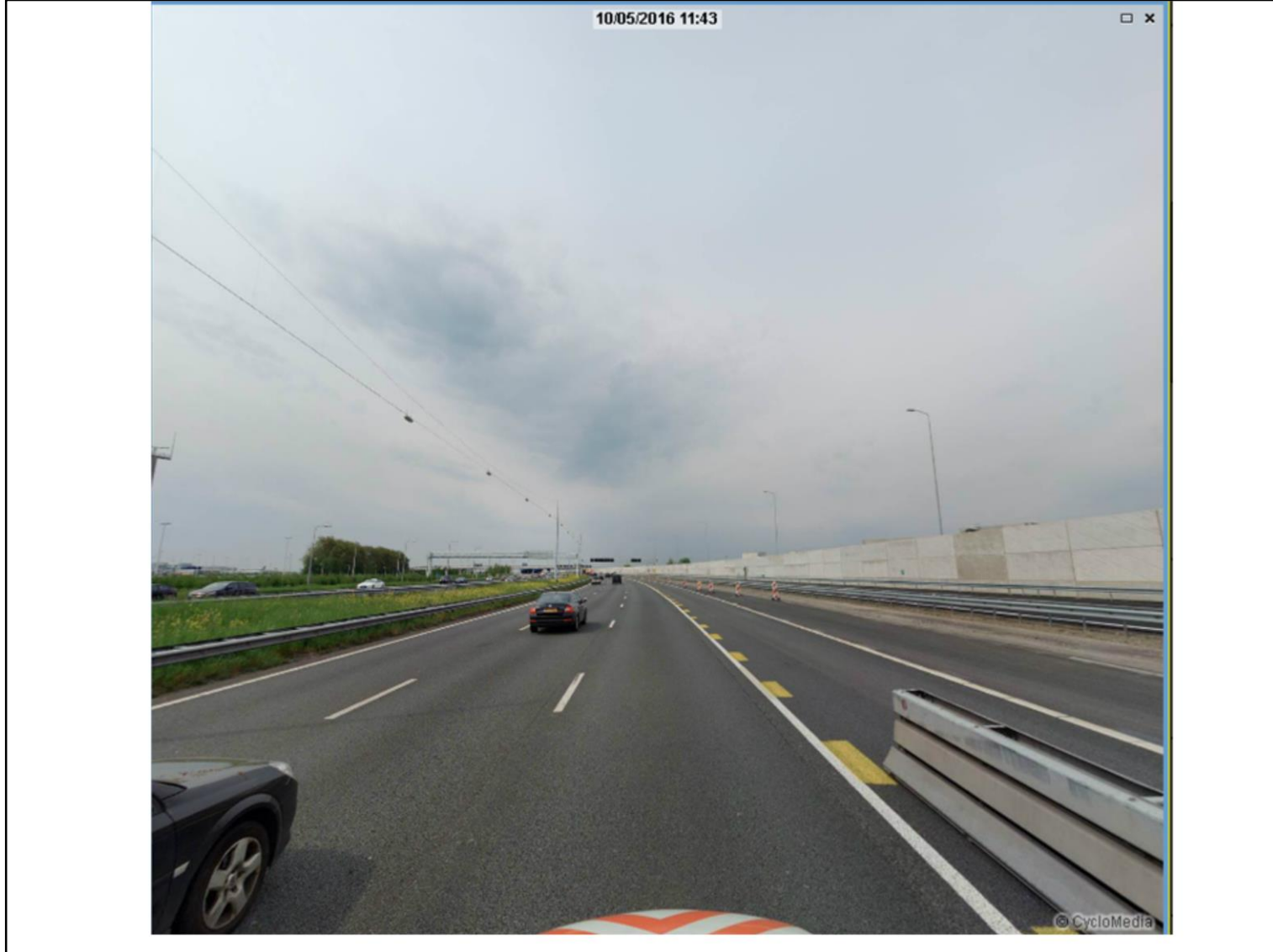
A4 hoofdrijbaan met 3 rijstroken knooppunt Badhoevedorp richting Schiphol tunnel, toekomstige samenvoeging 3+2 met de 2 rijstroken vanuit het 2+2 weefvak in de parallelbaan in aanleg (in mei 2016)
