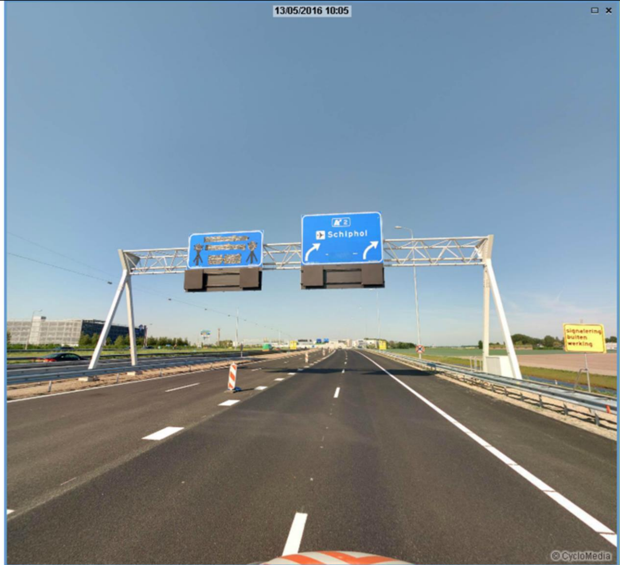
A4 parallelbaan ter plaatse van het 2+2 weefvak is gereed. De Linker 2 rijstroken richting hoofdrijbaan naar Den Haag zijn nog afgesloten.
